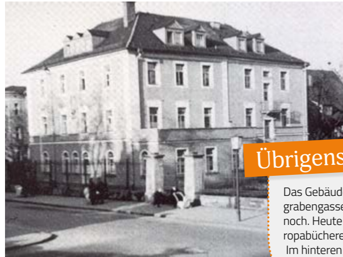
Das erstes Haus in der Schießgrabenstraße 2 in Passau
